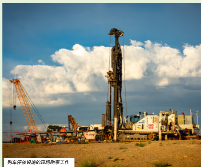
列车停放设施的现场勘察工作
