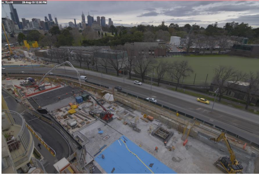
Final Pour and D-Wall Breakout
