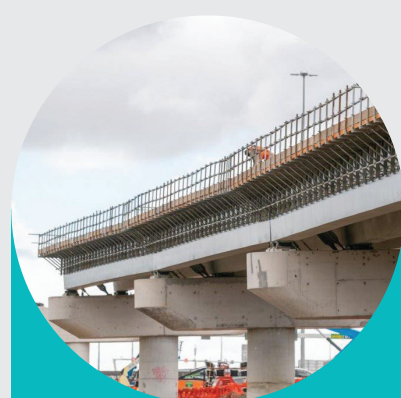
Đang tiến hành thi công đường dốc ở Hyde Street đi về phía thành phố
