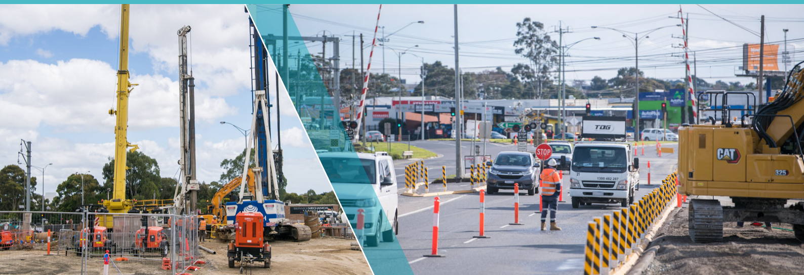
برمه کدن پایه های تهداب پل
