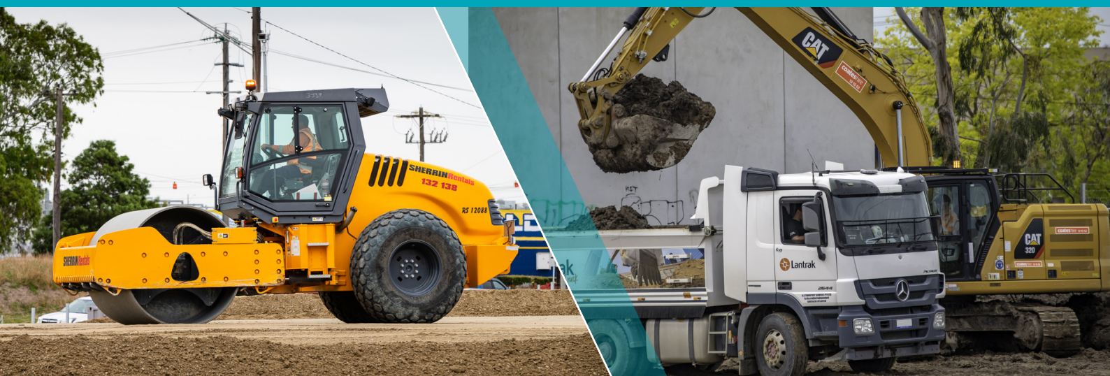
گلنگ های وزمین یک بستر محکم ره بلدی تهداب پل جدید میسازن
