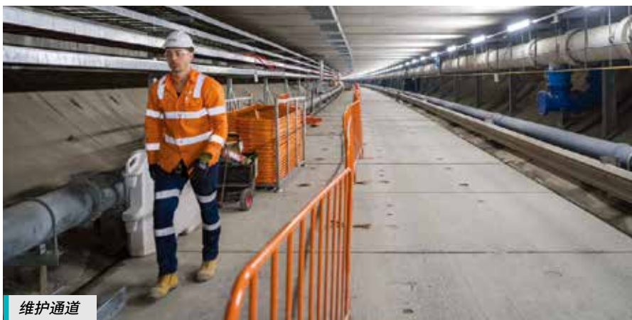
隧道电缆安装
