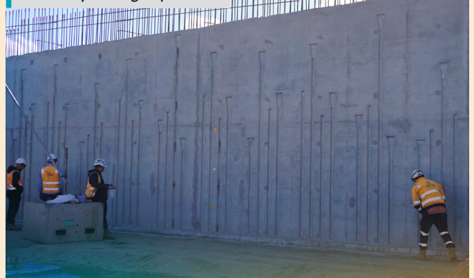
Các đội thi công trên tường mố cầu tại đường Hopkins
