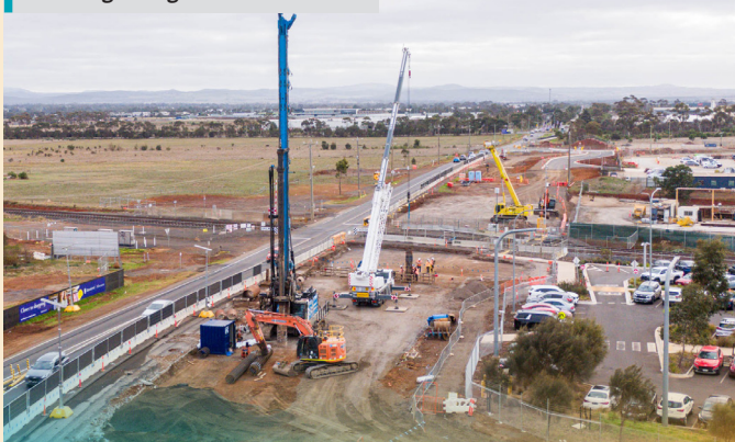
Máy đóng cọc tại đường Ferris thi công móng cầu.
