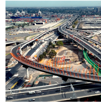
مداخل ومخارج نفق ويست غيت الجديدة فوق CityLink
