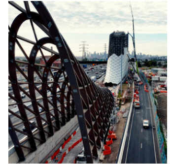
إطالة على مخرج النفق الخارجي باتجاه Geelong/Ballarat
