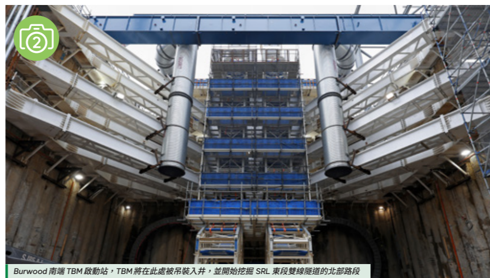
Burwood 南端 TBM 啟動站，TBM 將在此處被吊裝入井，並開始挖掘 SRL 東段雙線隧道的北部路段
