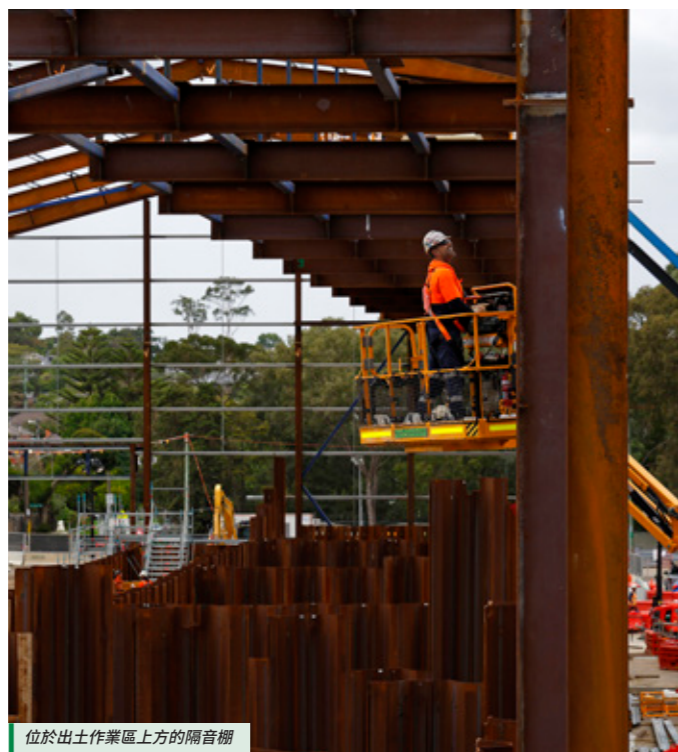
位於出土作業區上方的隔音棚
