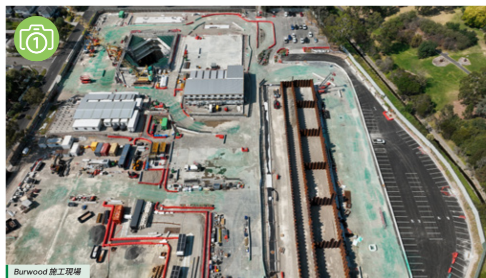
Burwood 施工現場
