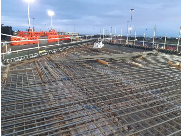
Bridge deck pour
