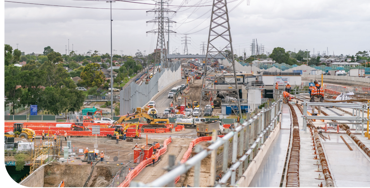
أعمال البناء في ويليامستاون رود (Williamstown Road) خلال حملة فترة الصيف
