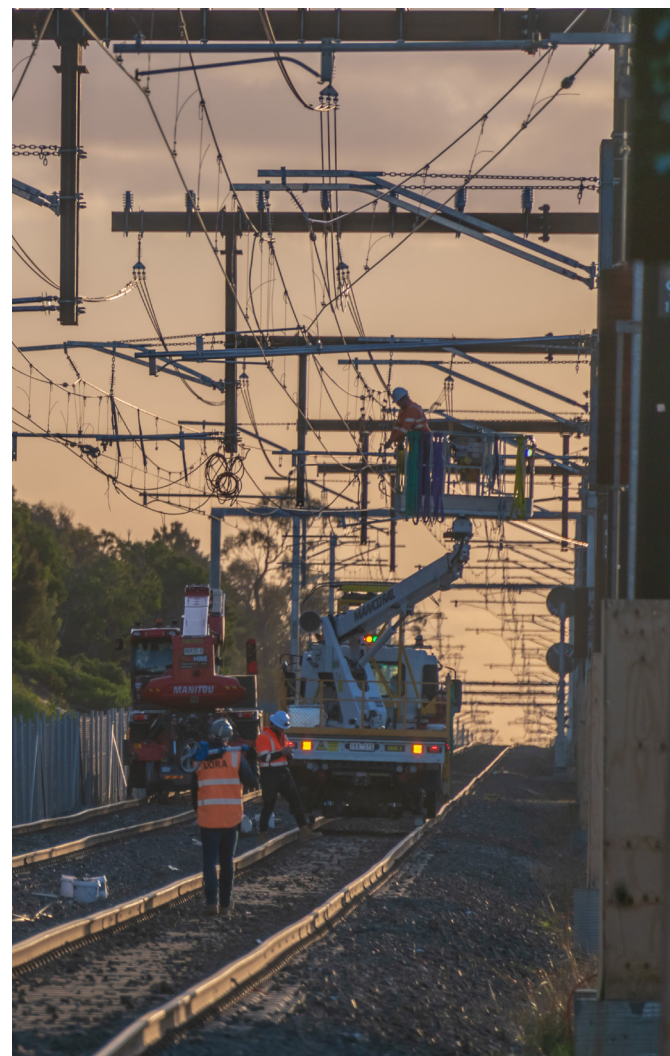
McGregor Road西面的悬挂工程
