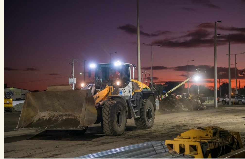
Pakenham车站硬地面铺设工程
