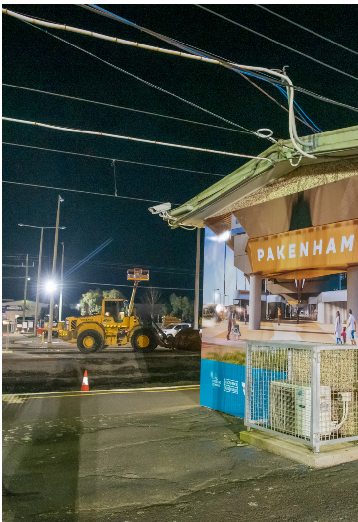
拆除铁轨侧线并为Pakenham车站场地做准备
