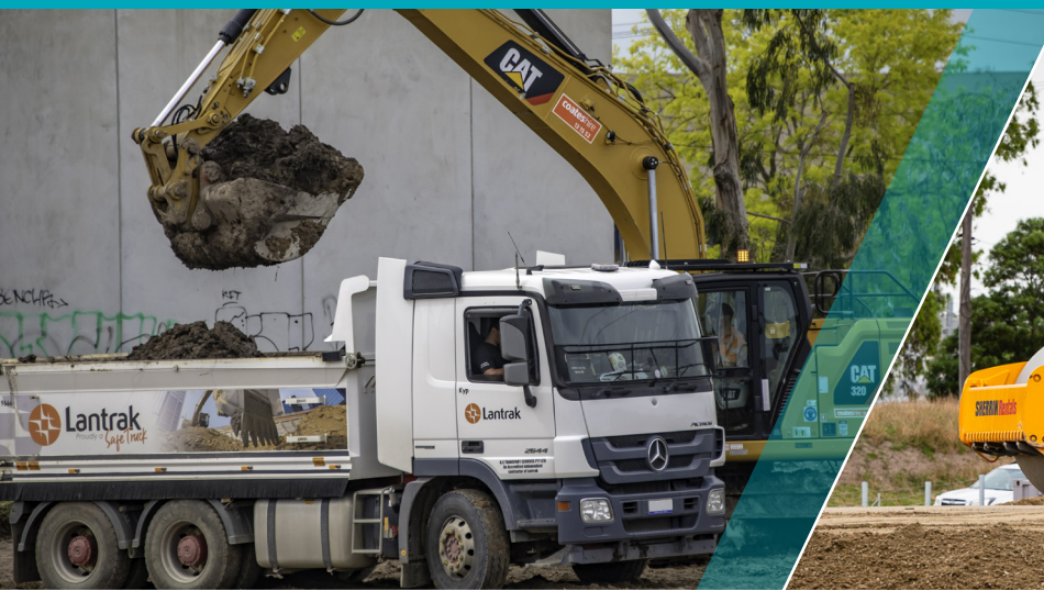
挖掘机和卡车运送泥土和其他建筑材料。
