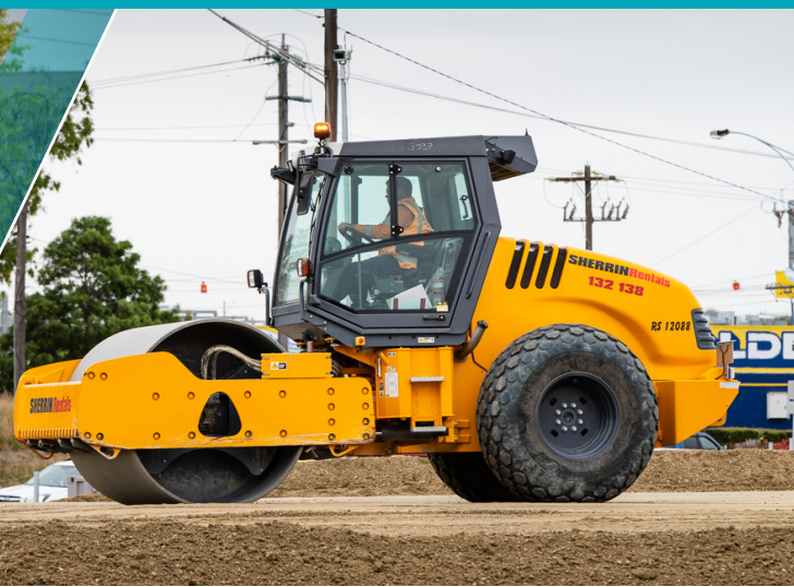
振动压路机为路桥打下坚实的地基
