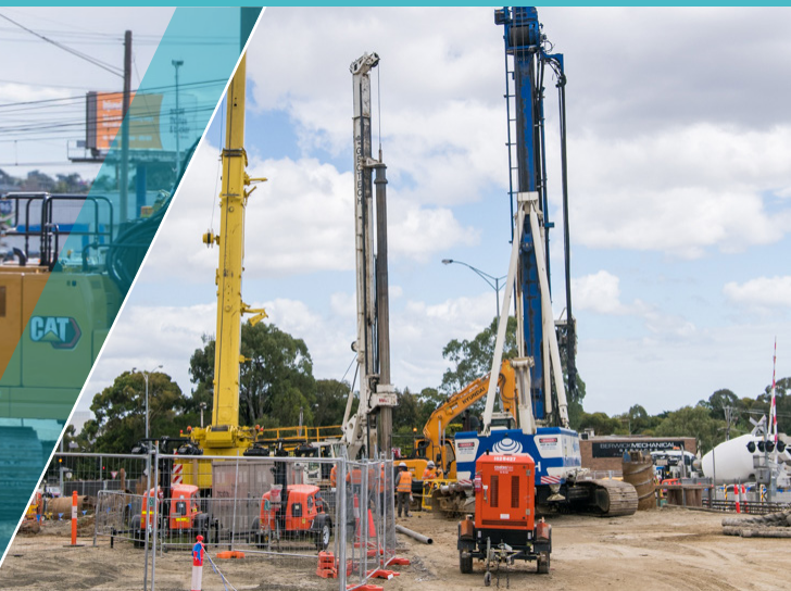
打桩机钻入桥梁地基
