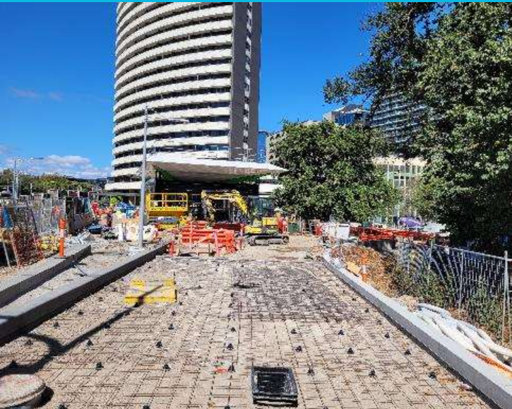
Concrete pour preparation
