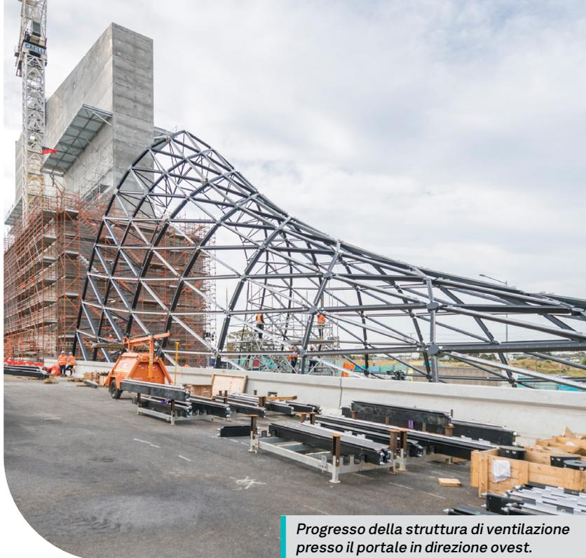
*Progresso della struttura di ventilazione presso il portale in direzione ovest.*
