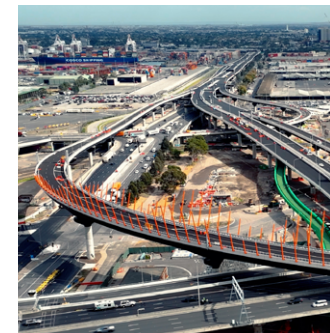
橫越 CityLink (墨爾本環城道路) 上方的西門隧道新匝道
