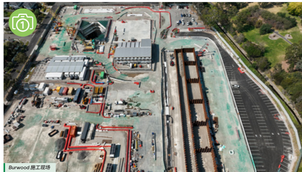
Burwood 施工现场
