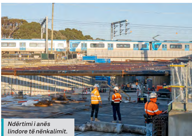
Këmbët mbështetëse të urës hekurudhore dhe hidroizolimi i bazamentit të nënkalimit.
