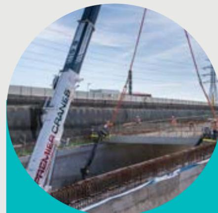
Installazione della soletta di copertura presso l'uscita del tunnel sulla West Gate Freeway.
