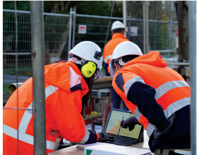
Glen Waverley SRL東段工地勘察
