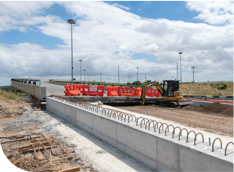
Κατασκευή νέας ράμπας στο M80 κατά τη διάρκεια των θερινών εργασιών
