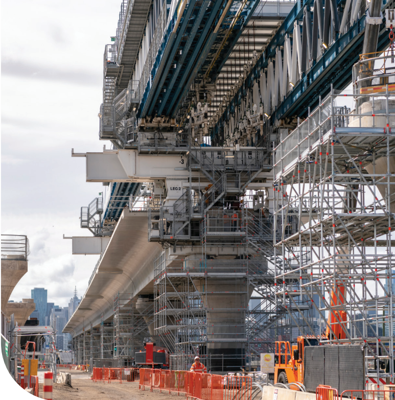
Φωτογραφία των ανοιγμάτων που έχουν κατασκευαστεί μέχρι σήμερα
