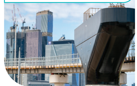
Εγκατάσταση σταυρωτής κεφαλής
