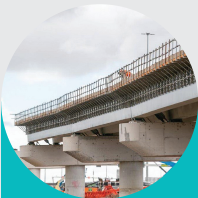
Σε εξέλιξη η κατασκευή ράμπας στο Hyde Street με κατεύθυνση το κέντρο
