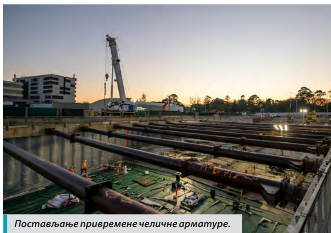
Потпорни елементи будућег централног саобраћајног дела, гледано ка истоку према Princes Highway-Lonsdale Street-у.
