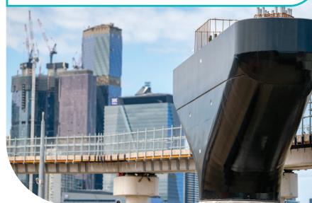
Installazione teste a croce
