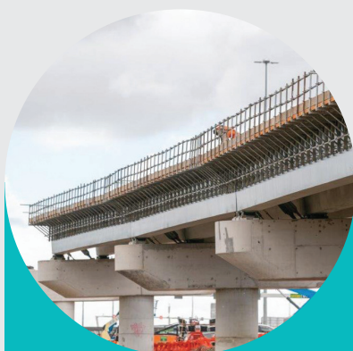
Sono in corso i lavori di costruzione della rampa di Hyde Street in direzione della città
