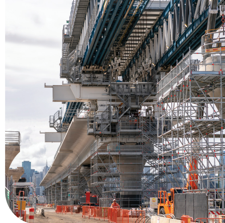
Foto delle campate costruite fino a oggi
