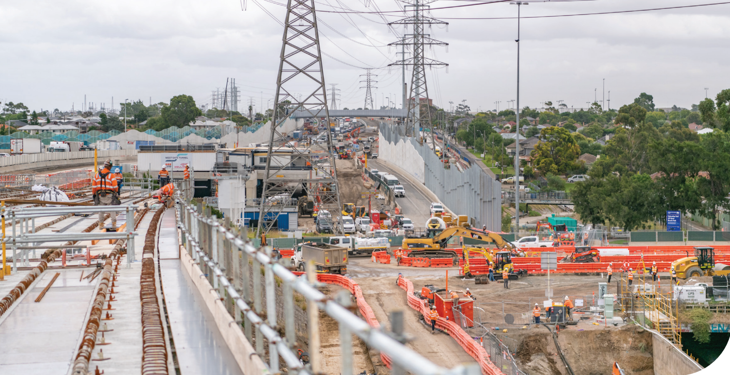
Attività di costruzione presso Williamstown Road durante la campagna estiva di lavori
