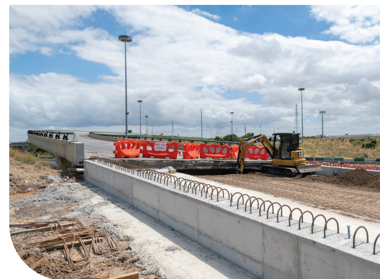
Costruzione di una nuova rampa presso la M80 durante i lavori estivi
