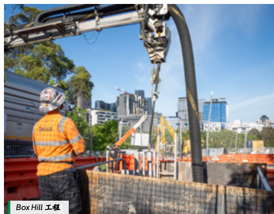
Box Hill 工程
