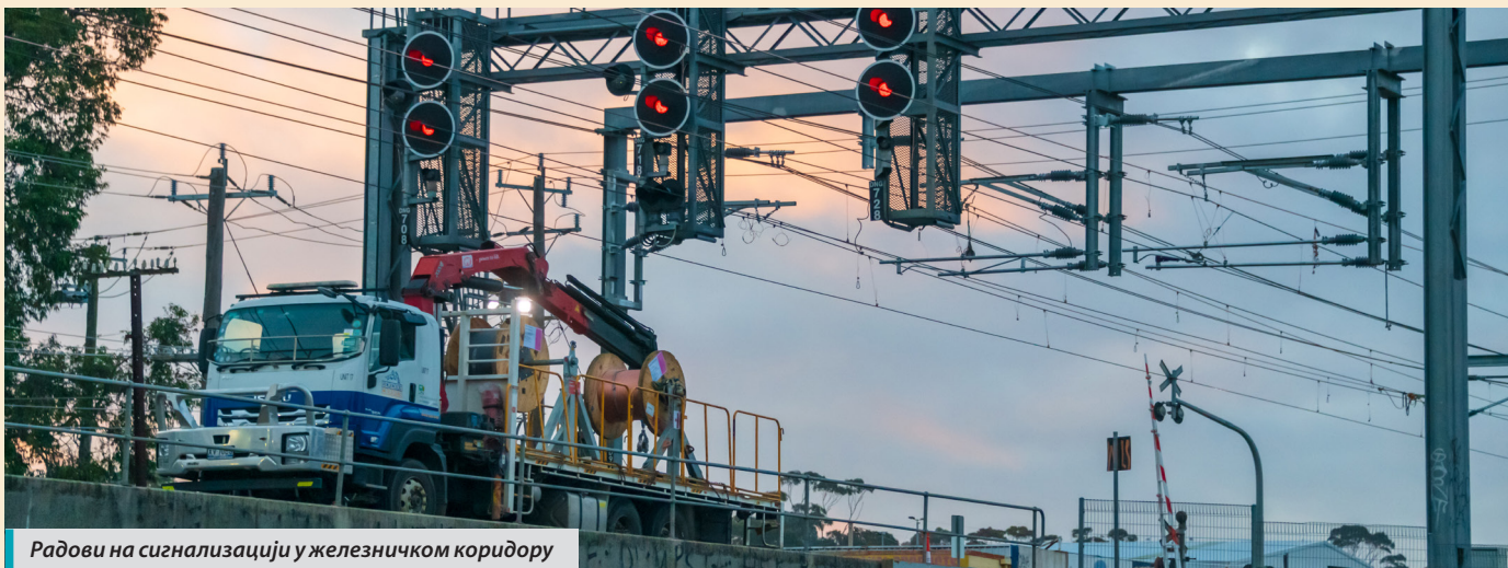
Радови на надземној кабловској инсталацији у железничком коридору
