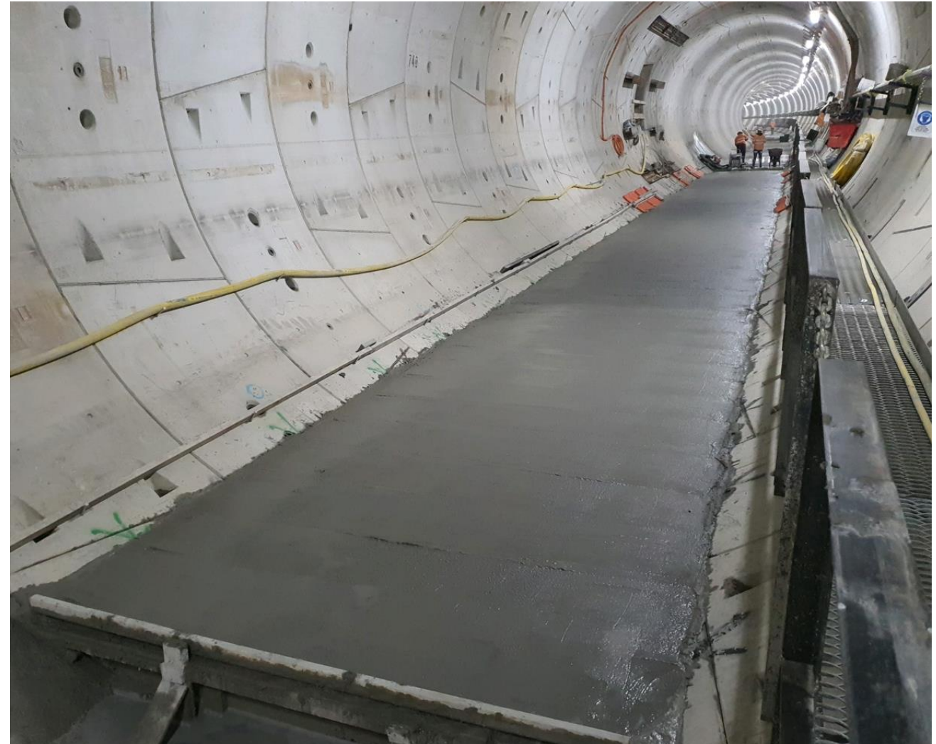
Invert pours underway
