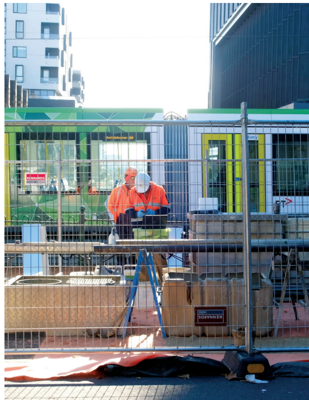
Box Hill的SRL東段工地勘察
