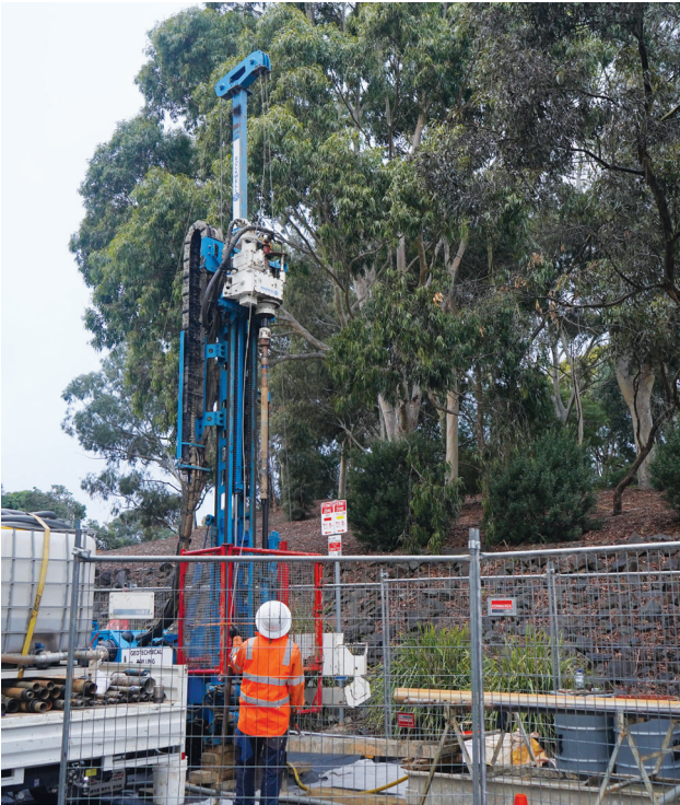
SRL East项目在Monash大学开展的现场勘查
