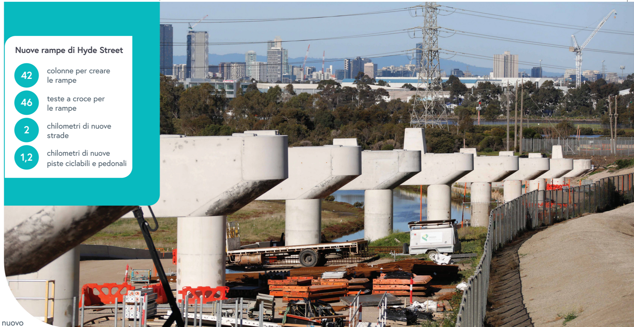
Costruzione delle rampe di Hyde Street vicino a Stony Creek
