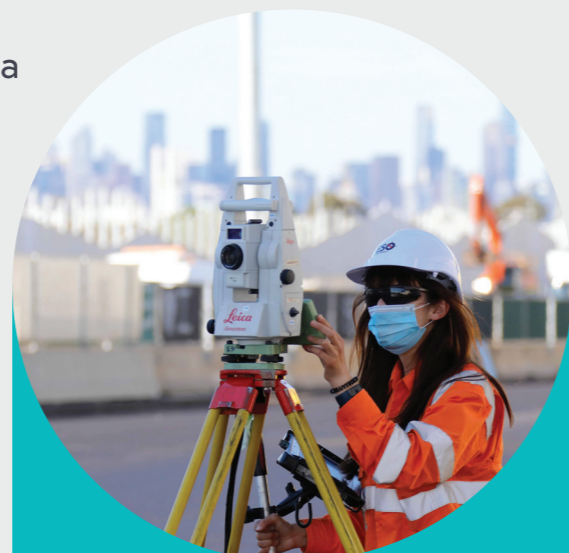
Ispezionando corsie di nuova costruzione sulla West Gate Freeway
