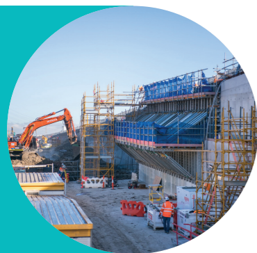
Scavi presso l'uscita del tunnel in direzione d'uscita
