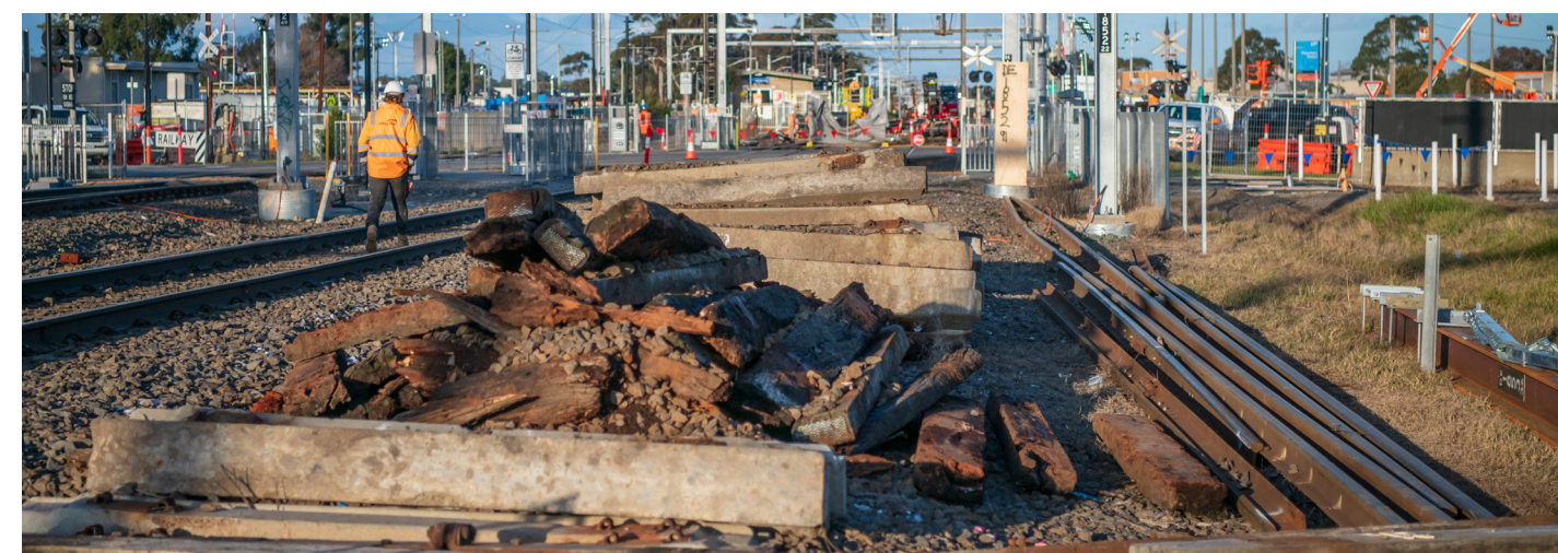
මේන් ස්ට්‍රිට් දුම්රිය හරහා දිවෙන පාරේ දුම්රිය මාර්ගය සහ සිල්පර ඉවත් කිරීම
