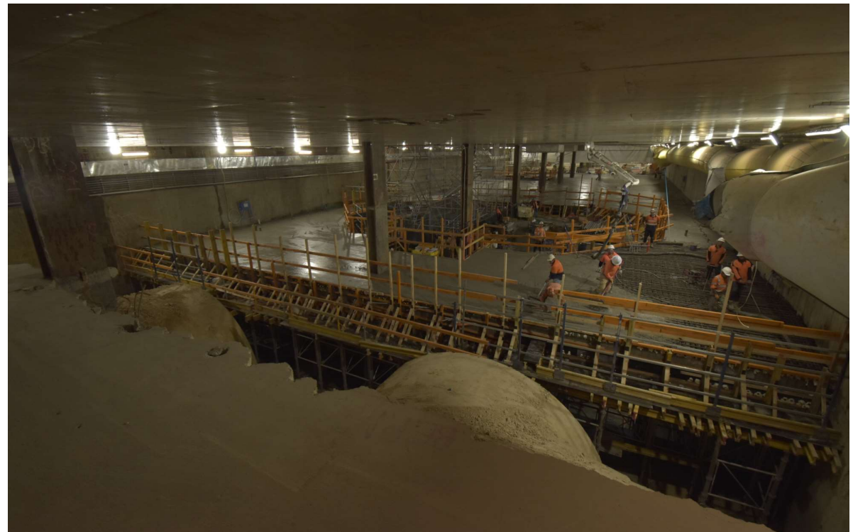
Largest concrete pour on the project to date
