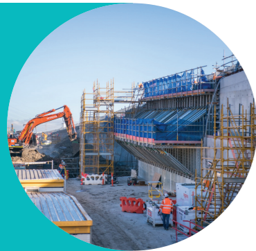
出城隧道出口处的挖掘
