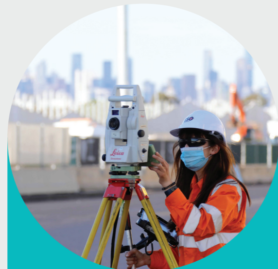
对西门高速公路上的新建车道进行勘测
