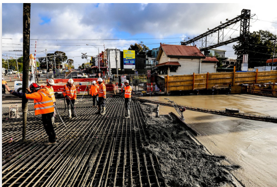
Concrete pour on bridge deck
