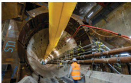
液压千斤顶会推动掘进机前进。掘进机向前移动时，厚厚的预制混凝土结构段被逐步安装在刀盘后方。这些混凝土结构段形成一个加固环，其设计旨在相互契合，为隧道创造一个永久衬砌。
