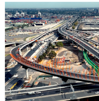
Các đoạn dốc mới của Đường hầm West Gate bắc qua CityLink
