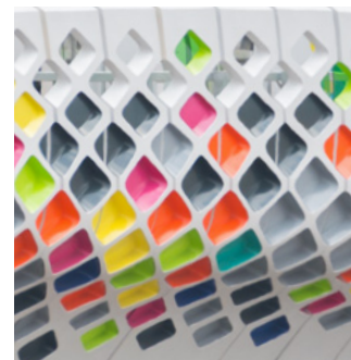
Lớp ốp trên cầu bắc qua Sông Maribyrnong được lấy cảm hứng từ làn da của cá và lược
