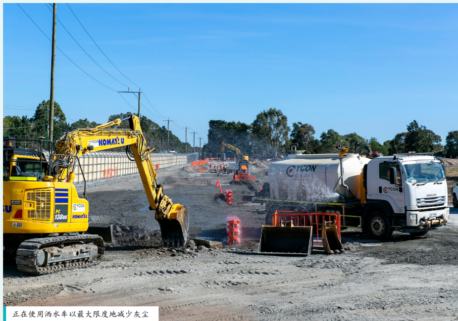
正在使用洒水车以最大限度地减少灰尘
