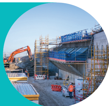
Εκσκαφή στην έξοδο της εξερχόμενης σήραγγας
