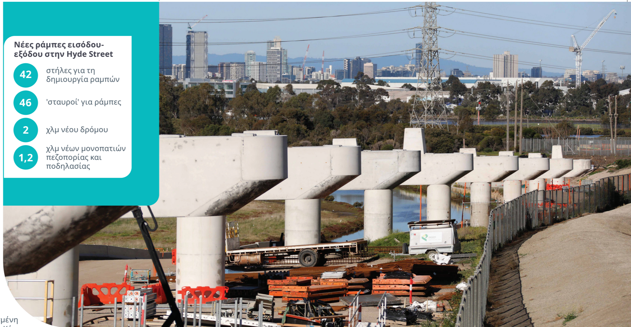
Κατασκευή ραμπών εισόδου-εξόδου στην Hyde Street δίπλα στο Stony Creek
