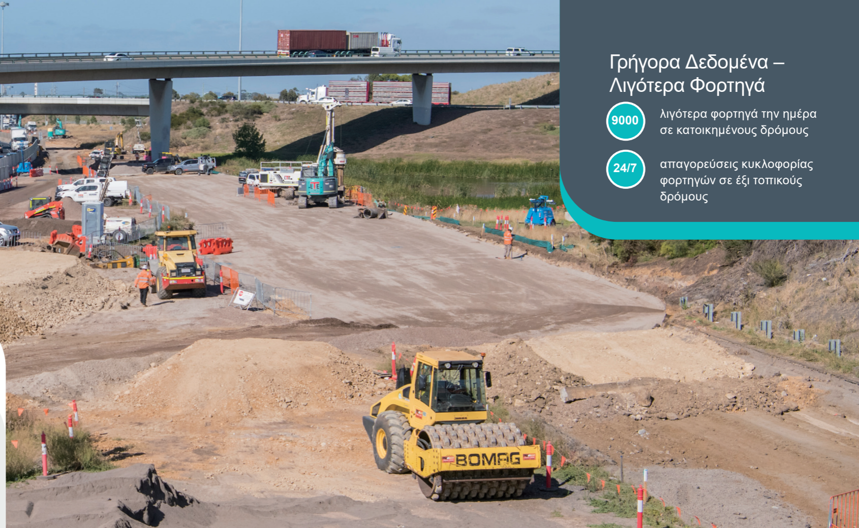
Η επανευθυγράμμιση της ράμπας εξόδου της Geelong Road είναι σε λειτουργία.
