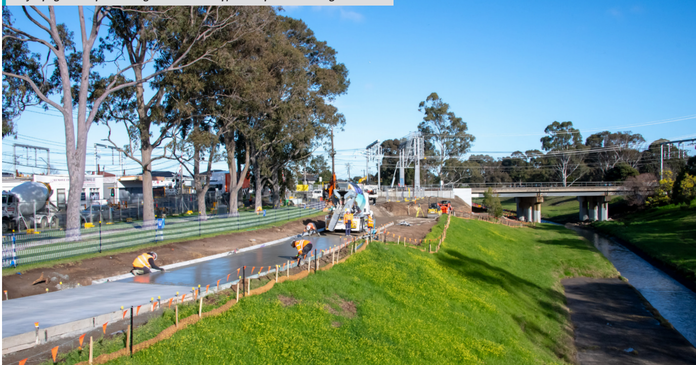
Xây dựng lối đi bộ và đường dành cho xe đạp mới dọc theo đường Webster
