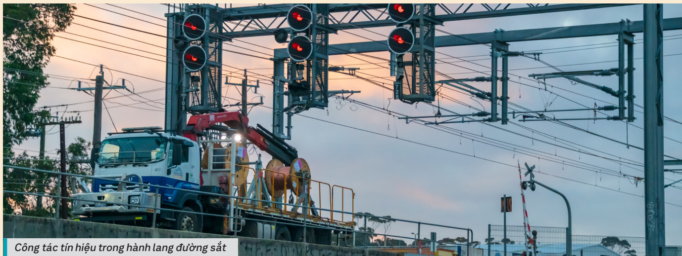
Công tác lắp đặt hệ thống dây điện trên cao trong hành lang đường sắt
