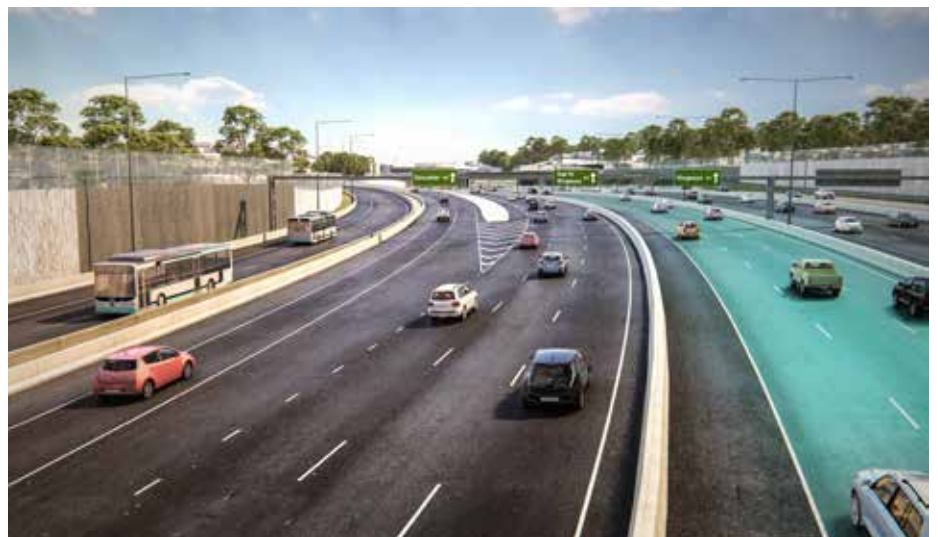
Καινούργιες λωρίδες στο Eastern Freeway και Λεωφορειολωρίδα Doncaster
