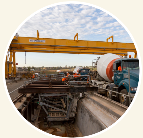
Final L-beam pour out at Kilmore
