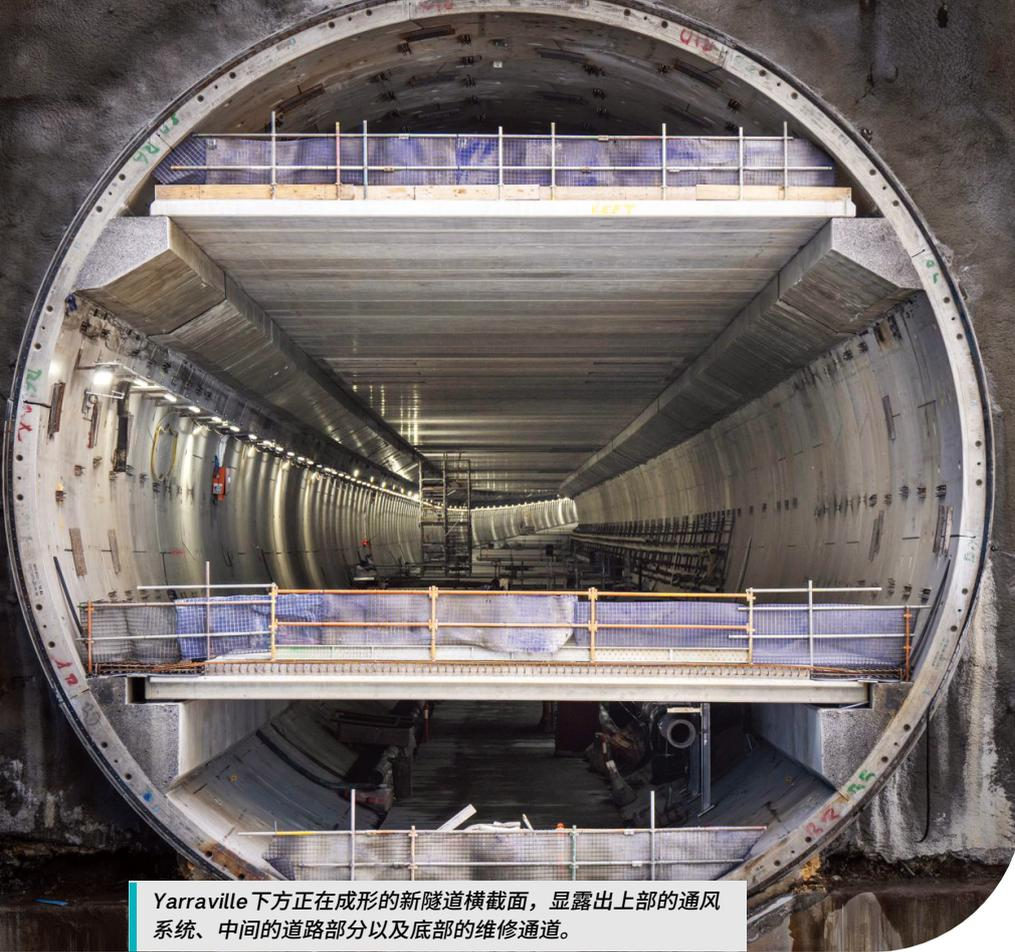
Yarraville下方正在成形的新隧道横截面，显露出上部的通风系统、中间的道路部分以及底部的维修通道。
