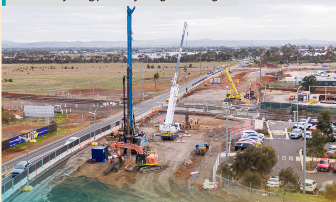
Mga piling rig sa Ferris Road para sa konstruksyon ng pundasyon ng road bridge.
