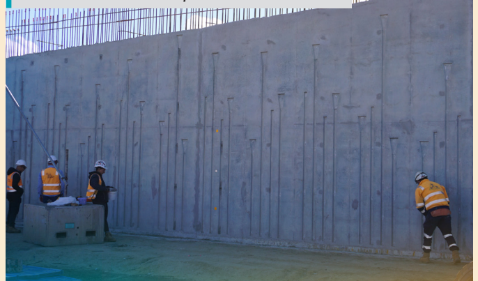
Mga pangkat ng trabahador na nagtatrabaho sa abutment wall sa Hopkins Road.
