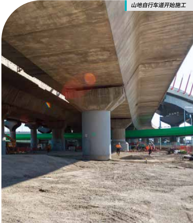
山地自行车道开始施工
