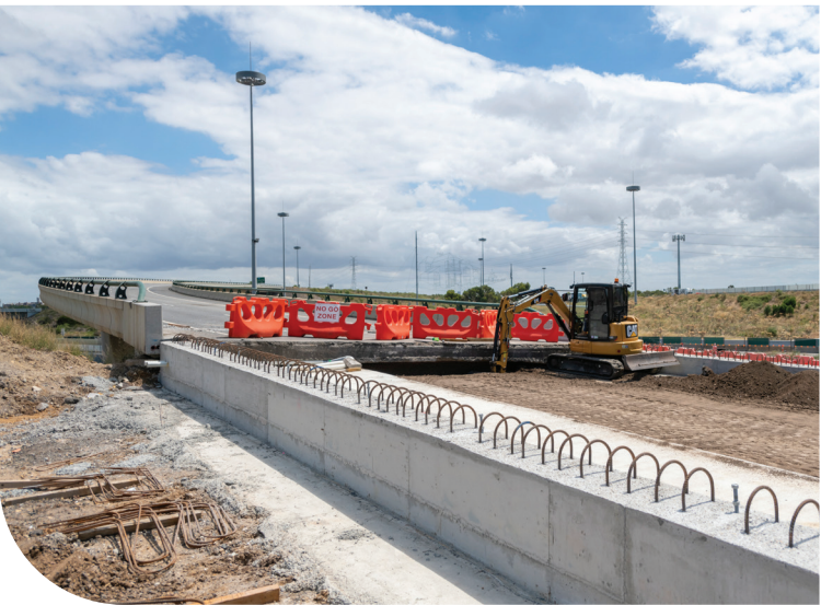
夏季施工期间在M80环线建一条新的匝道
