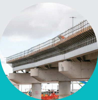
进城方向的 Hyde Street匝道正在施工中
