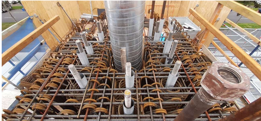
Footscray Road portal concrete pour
