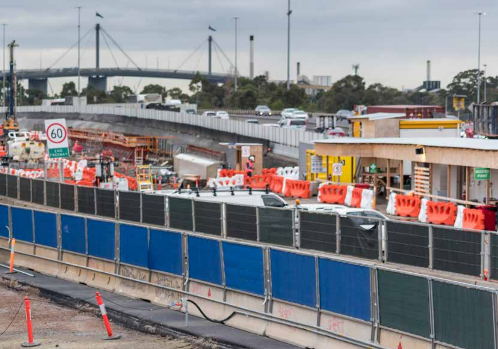
Εργασίες διαπλάτυνσης του Αυτοκινητόδρομου West Gate
