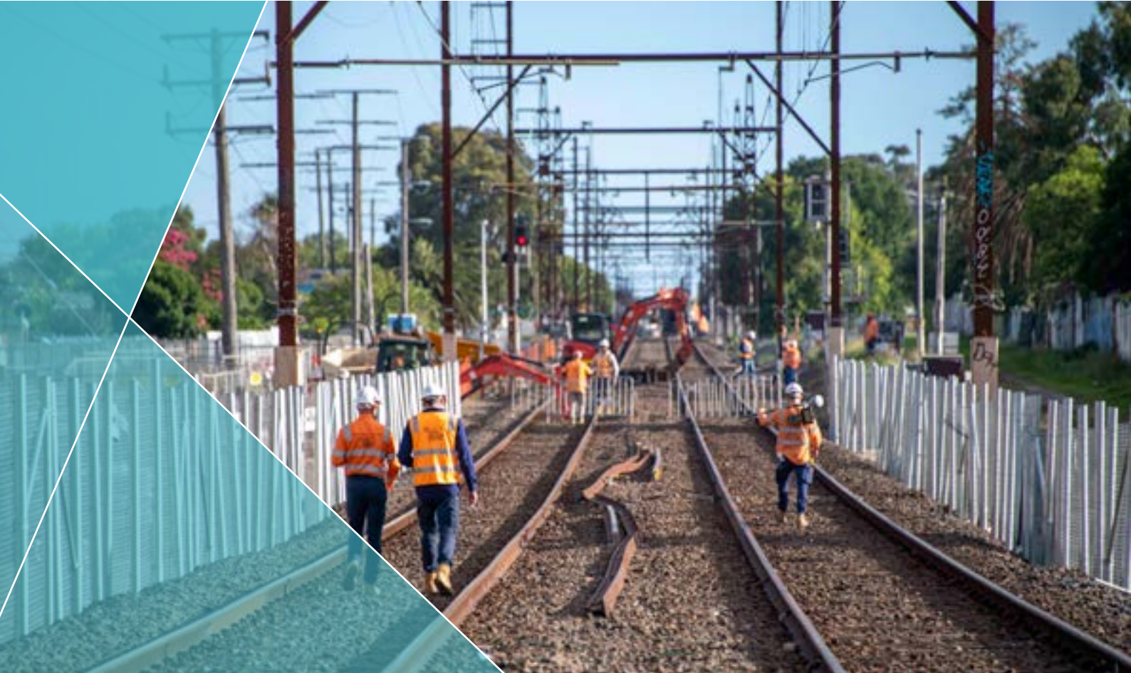
Preston平交道口拆除项目正在开展施工。
