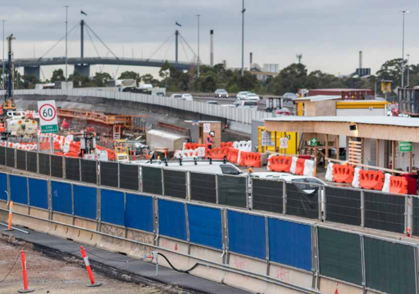
Lavori di ampliamento della West Gate Freeway
