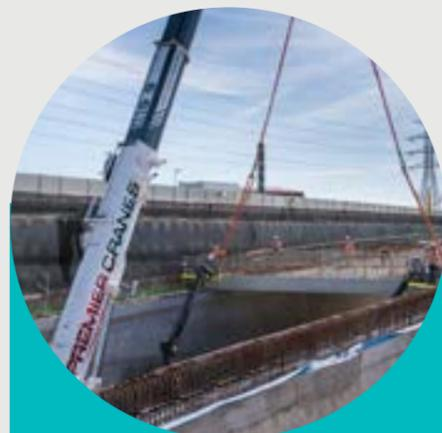
在西门高速公路出城方向的隧道出口处搭建顶板平台。
