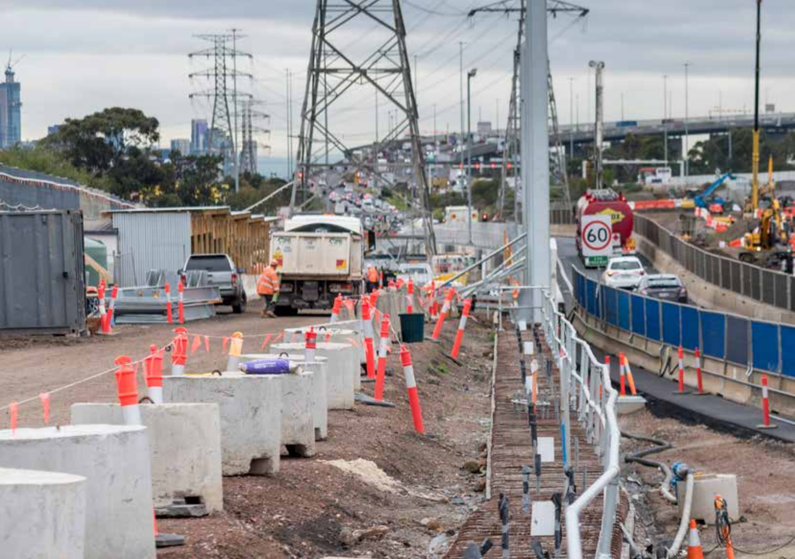
أعمال توسيع طريق West Gate السريع
